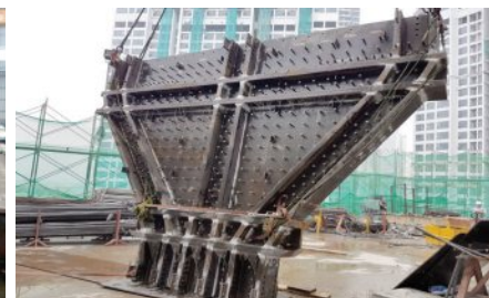
TRANSFER BEAM | DẪM CHUYỀN
